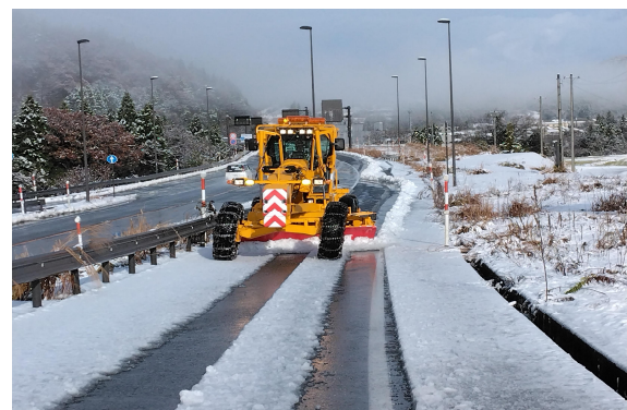
したほく 国道41号 富山市下夕北ICにおける作業状況
