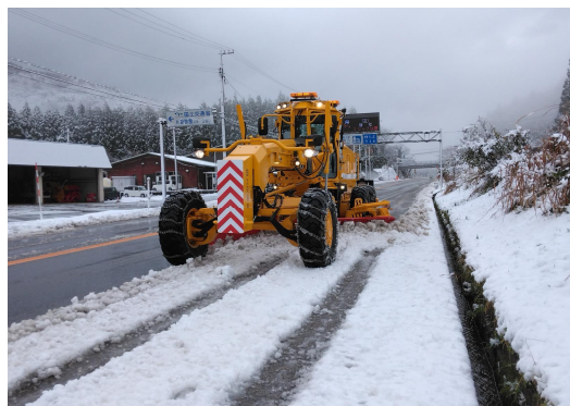
かたかけ 国道41号 富山市片掛における作業状況 <過去初出動との比較>
