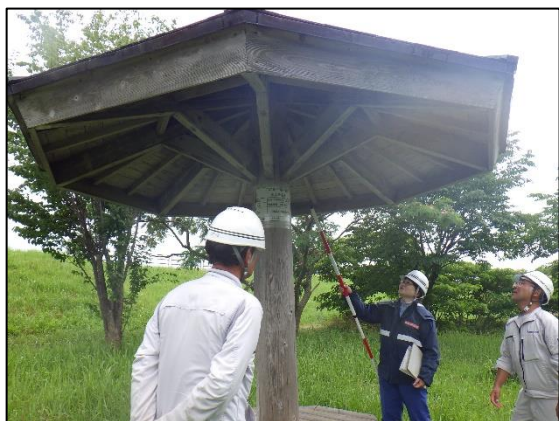
庄川・清水公園 【四阿へのスズメバチ営巣 有無の確認】
