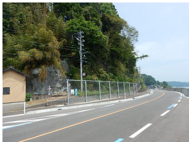
防災工事実施後（同箇所：R3年4月）
