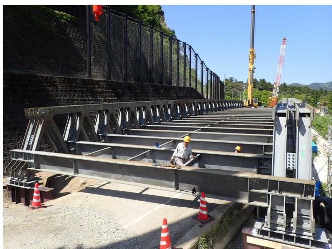
応急組立橋の床桁架設状況
