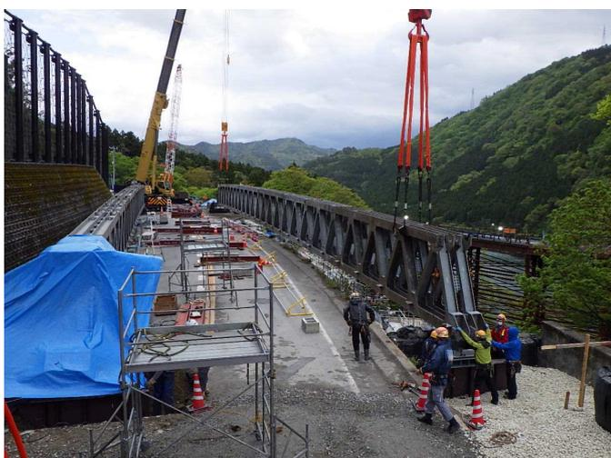
応急組立橋の主桁架設状況
