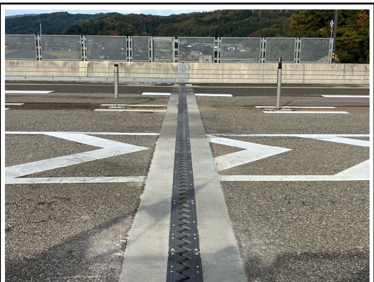
橋梁の補修状況
