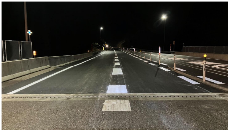
舗装の補修状況
