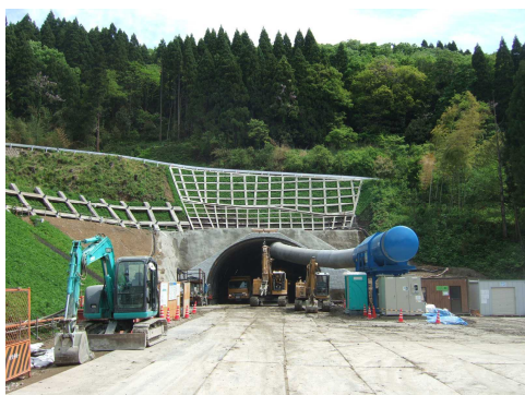
氷見第15トンネル高岡側抗口
