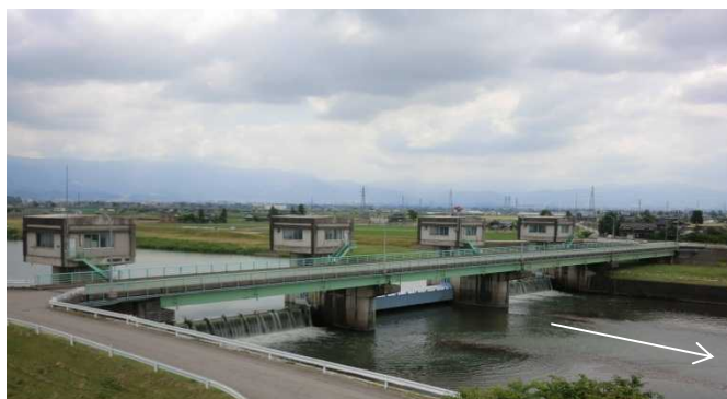
小矢部大堰全景（右岸下流側より、上流側を望む）
