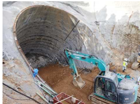
「斜め深礎杭」の施工状況
