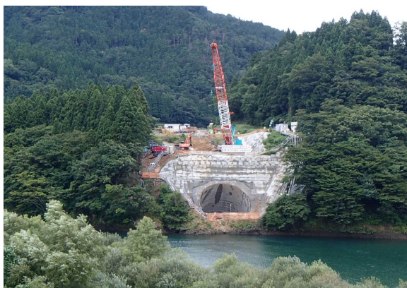
工事の状況(対岸から撮影)
