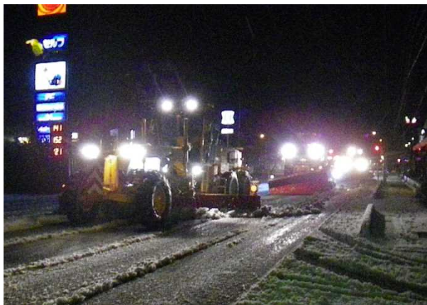
夜を徹して作業にあたる除雪グレーダ (国道8号高岡市六家地先)
