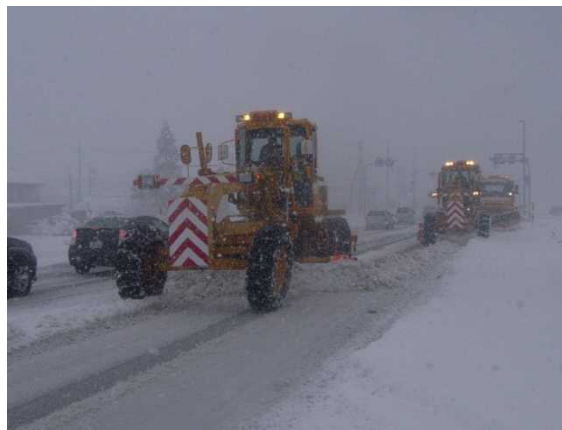
降りしきる雪の中で道路の確保にあたる除雪グレーダ (国道8号滑川市大掛地先)
