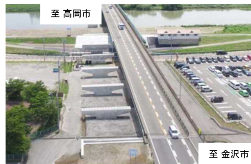
茅蜷橋橋梁工事施工状況（左岸側）
