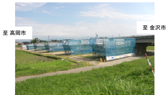
茅蜷橋橋梁工事施工状況（右岸側）
