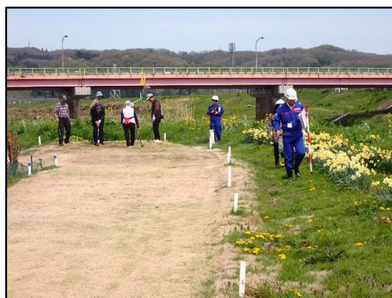
小矢部川国条橋自由広場 【河岸の欠損・立入注意喚起状況】
