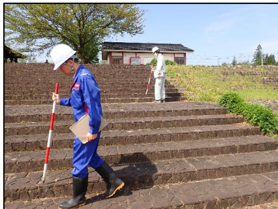
神通川水辺プラザ 【古木枝の落下、護岸の空洞】
