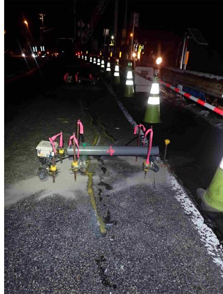
● 地盤変状計測用のボーリング(深さ20m×2箇所)
