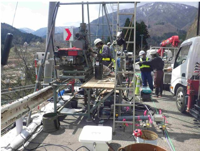
● 地盤変状計測機器(1箇所)設置完了
