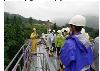
工事現場見学(昨年の状況)
