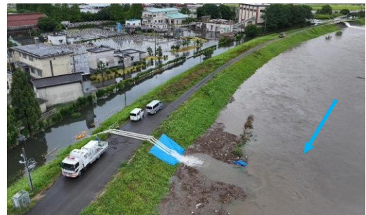
四谷排水機場(小矢部川(高岡市))
