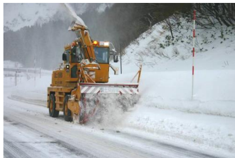
拡幅除雪の状況
