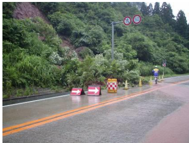
法面崩壊、土砂流出状況
