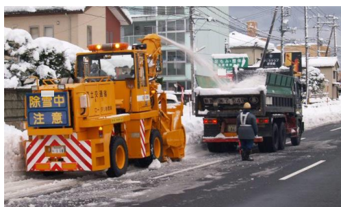
運搬排雪の状況
