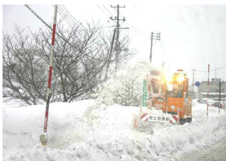
歩道除雪の状況
