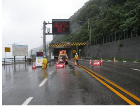
異常時における通行規制状況
