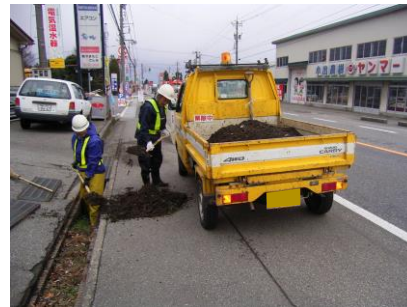
側溝清掃の状況
