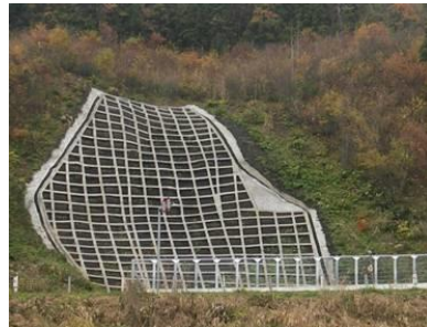
法枠による対策状況
