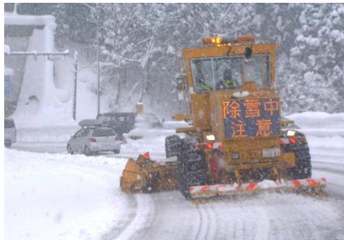
路面整正の状況
