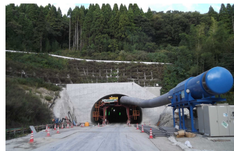
氷見第15トンネル高岡側坑口
