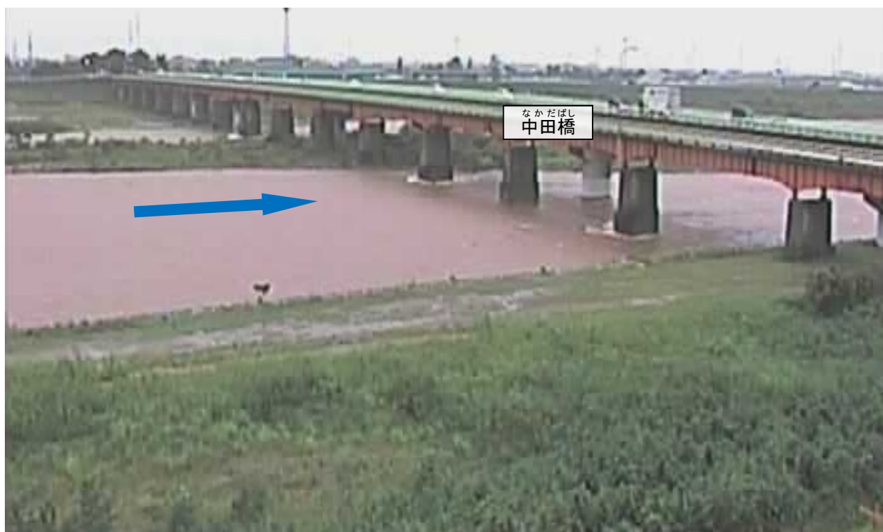
庄川右岸 13.6k 付近（富山県高岡市上麻生 かみあそ ）出水状況（9/20 17:30 頃）
