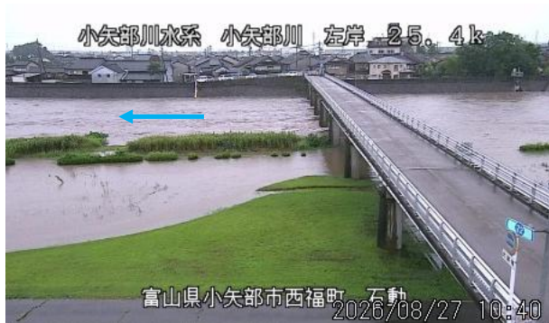
小矢部川 石動観測所付近 (8月27日 10:40頃)
