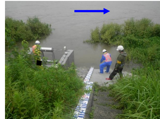
構造物状況 (小矢部川右岸4.2k)
