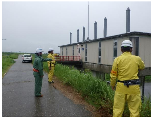
構造物状況 (小矢部川右岸15.4k)
