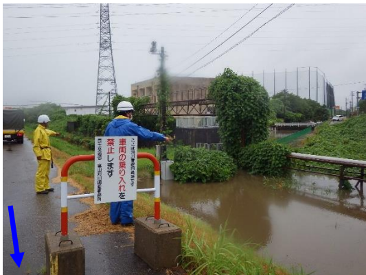
川裏浸水状況 (小矢部川左岸3.6k)
