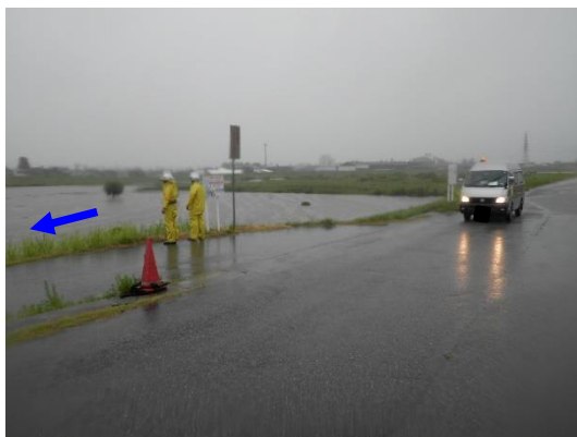
河道状況 (小矢部川左岸11.4k)
