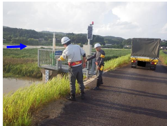
構造物状況 (小矢部川右岸3.6k)
