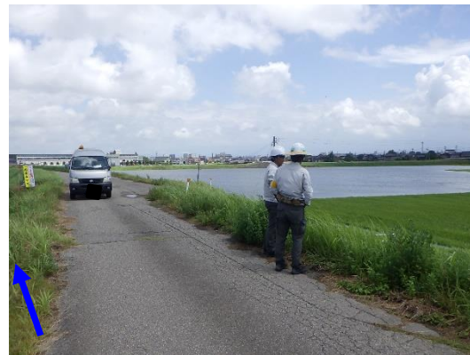
川裏浸水状況 (小矢部川右岸13.0k)
