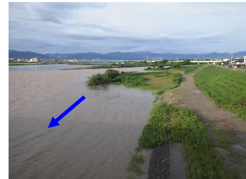
神通川流下状況確認 (神通川左岸8.0k)
