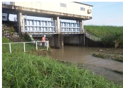
神通川馬渡川排水樋門状況確認 (神通川左岸5.2k+100)
