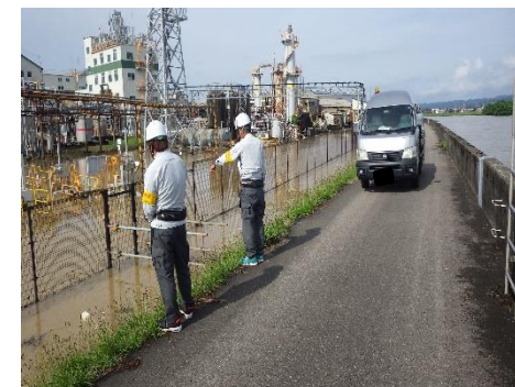
小矢部川 浸水被害状況確認 (小矢部川右岸5.6k)
