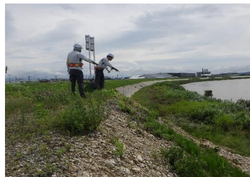
小矢部川堤防坂路状況確認 (小矢部川右岸8.8k)
