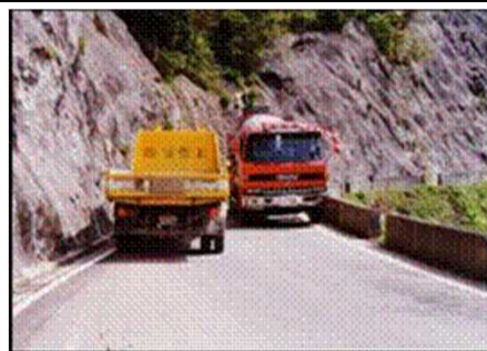
一般国道471号(現道)
