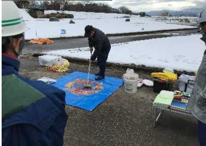
吸着材による油の回収作業の様子
