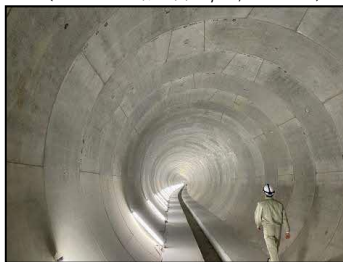
雨水貯留管内部 (仕上がり内径φ5,250mm)
