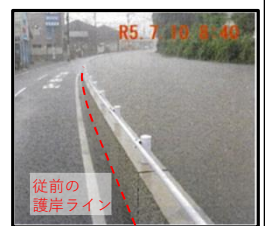
<池町川護岸嵩上げ>
