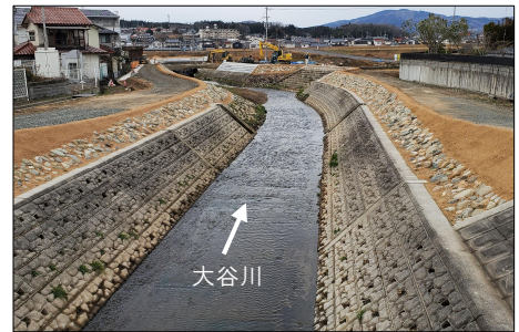
広島県による支川の改修
