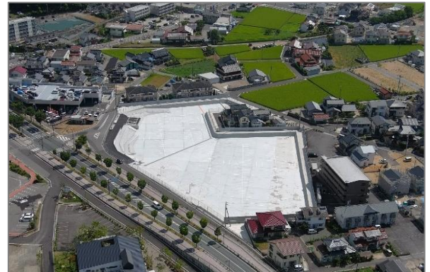
三次市による雨水貯留施設の整備
