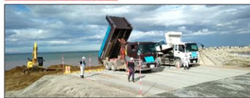
養浜材の荷下・投入状況 (R4.8.18 撮影)
