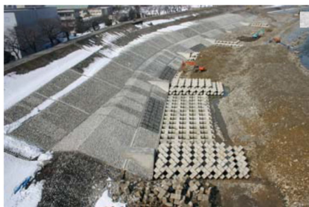
急流河川対策(根継ぎ護岸)
