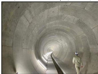
雨水貯留管内部 (仕上がり内径φ5,250mm)
