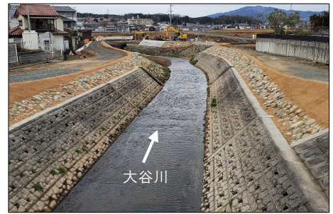
広島県による支川の改修
