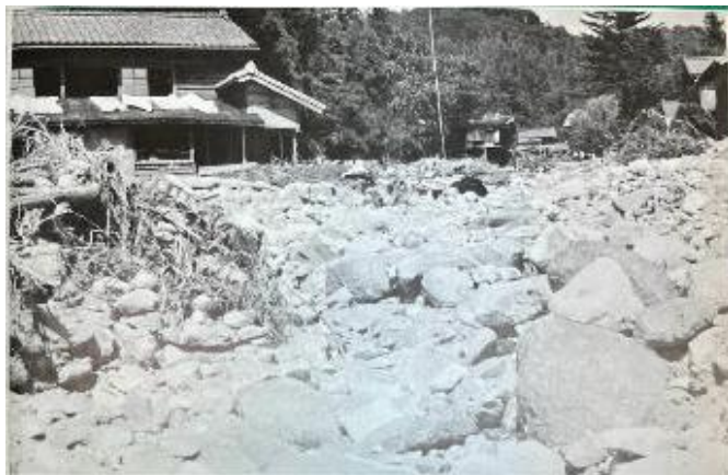
「羽越水害」の被害写真
