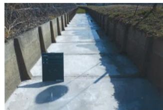
底張りコンクリート
