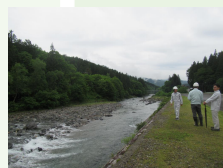
地域の消防署との危険箇所確認
