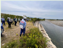
水防河川巡視
