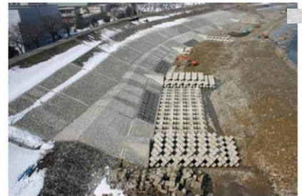
急流河川対策(根継ぎ護岸)
