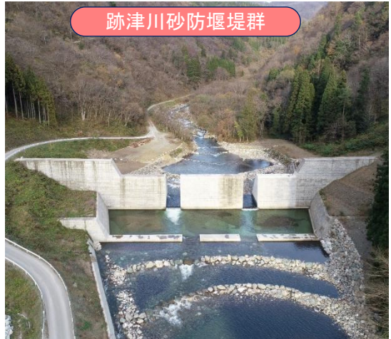
対策による効果(土砂・流木捕捉) 整備例
