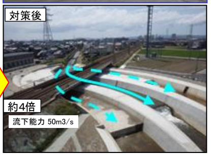
ボトルネックとなっていた鉄道橋を河道拡幅し流路を1本から3本に改修
