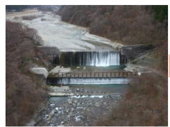
対策による効果(土砂・流木捕捉) 整備例
