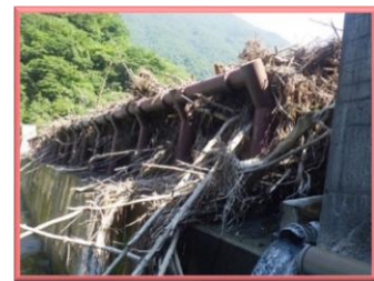
対策による効果(土砂・流木捕捉) 整備例
