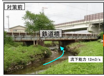
ボトルネックとなっていた鉄道橋を河道拡幅し流路を1本から3本に改修
