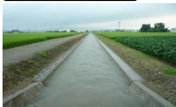
水路の改修（大断面化）
