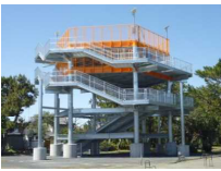
津波避難タワー
