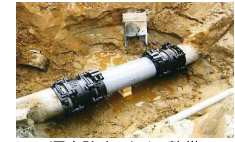
漏水防止のための整備
