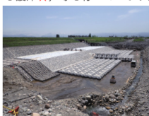
▲工事状況(令和4年5月)
