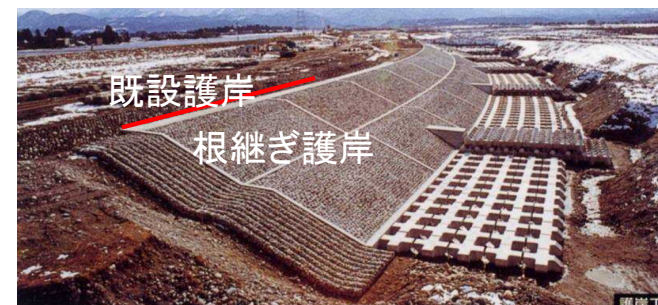
急流河川対策(根継ぎ護岸)
