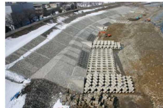
急流河川対策(根継ぎ護岸)
