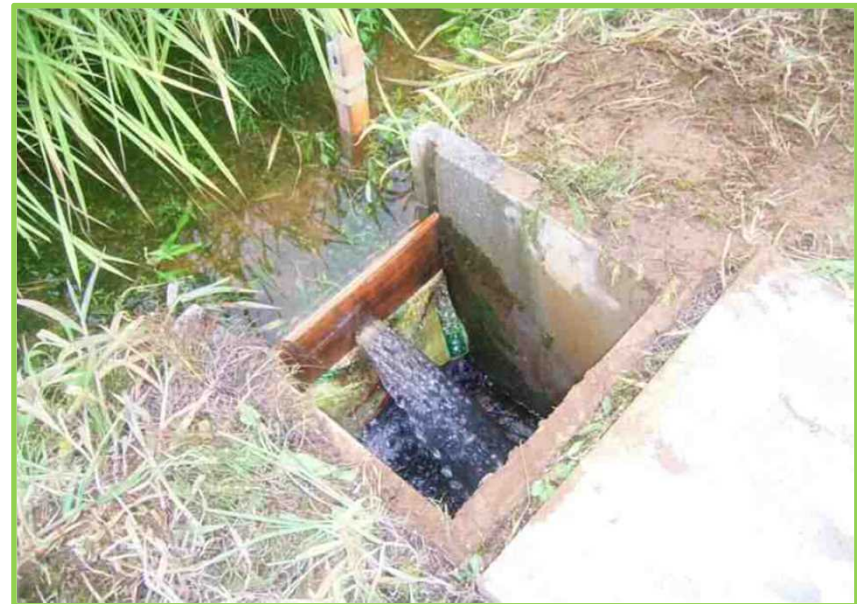
堰板設置状況
