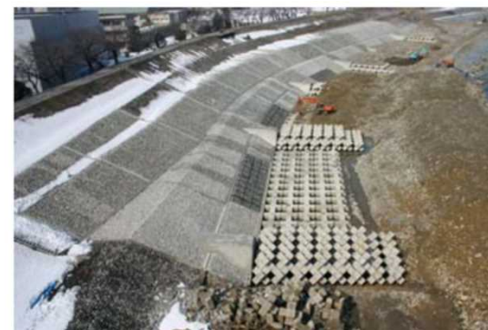
急流河川対策(根継ぎ護岸)
