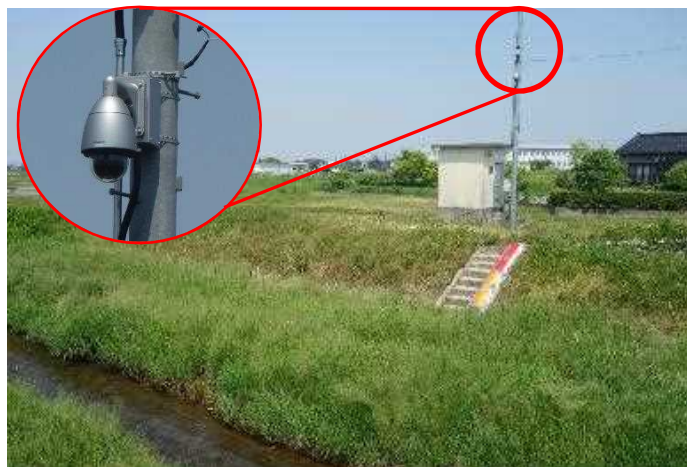
河川監視カメラ設置状況
