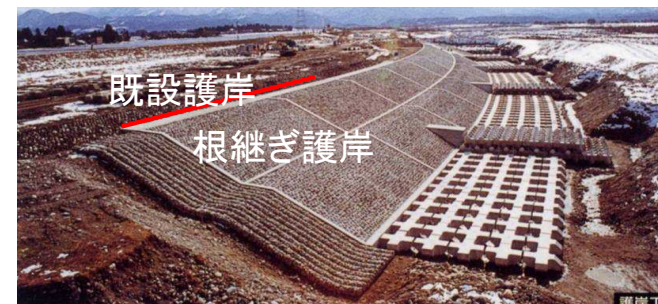
急流河川対策(根継ぎ護岸)
