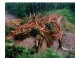
流木捕捉式治山ダム
