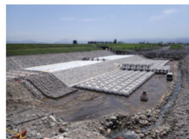
▲ 工事状況(令和4年5月)
