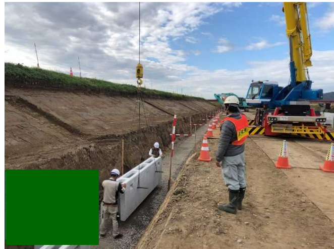
プレキャスト製品等による施工状況 (法留基礎、大型ブロック)
