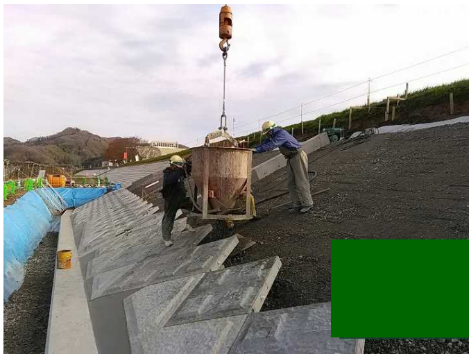
プレキャスト製品等による施工状況 (法留基礎、大型ブロック)
