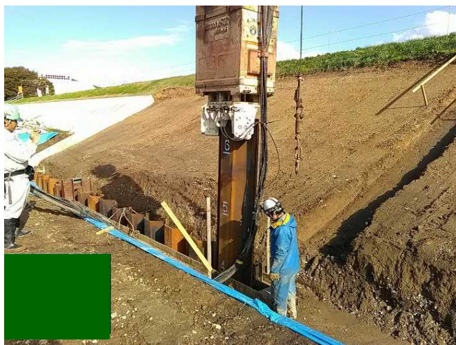
ハット型鋼矢板による施工状況 (浸透対策)
