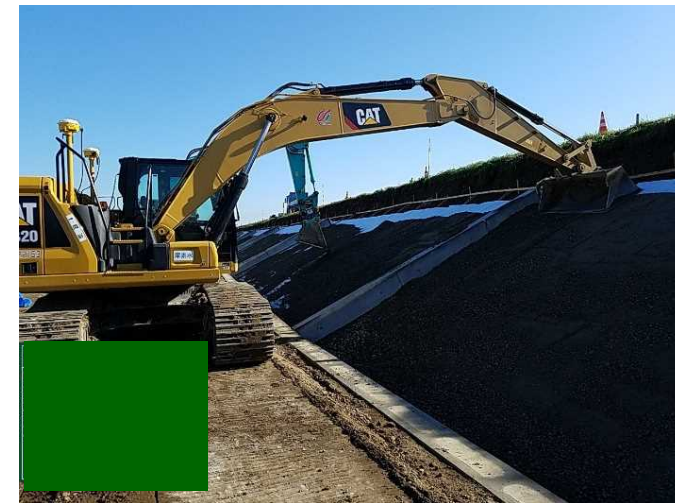
ICT機械による施工 (法面整形工)
