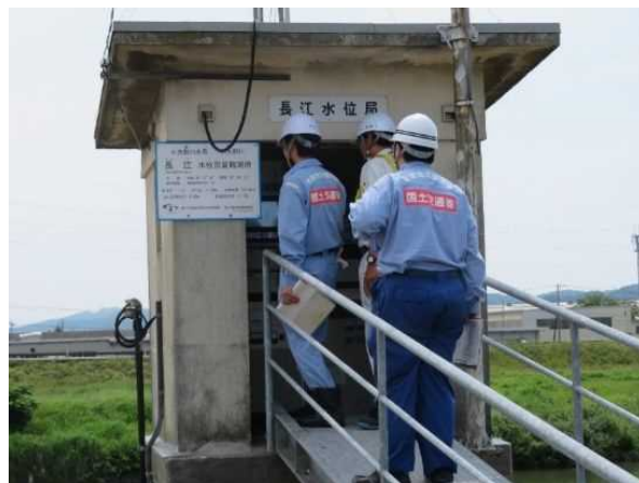
雨量・水位観測所点検
