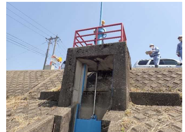
樋門の操作点検
