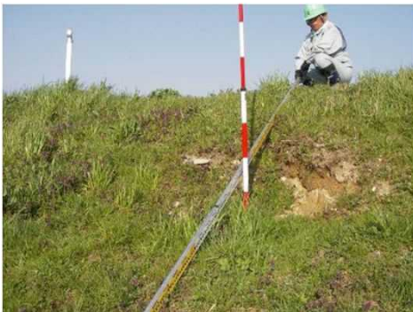
河川管理施設(堤防)の点検
