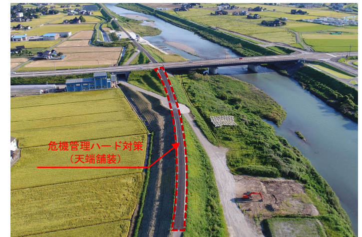
危機管理型ハード対策（天端舗装）実施状況
