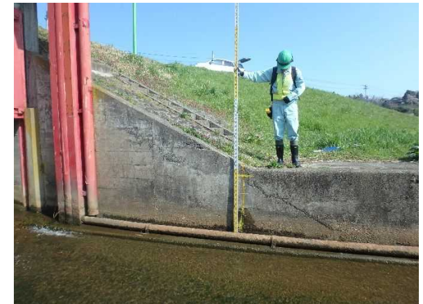
樋門・樋管点検
