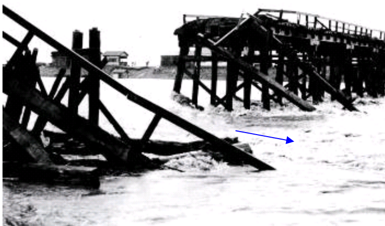
落橋した国条橋（高岡市） こくじょう
