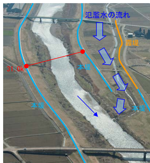
写真 3.2 左岸 31.0km 付近の霞堤
