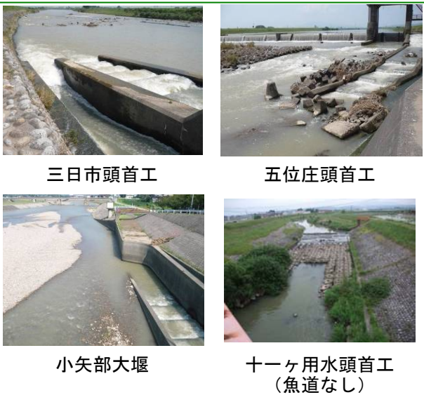
写真 3.11 横断工作物の魚道の設置状況
