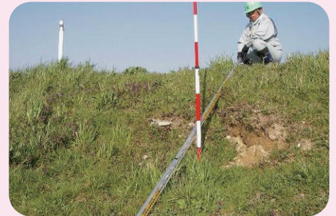
▲河川管理施設（堤防）の点検
