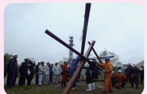
▲水防工法研修
