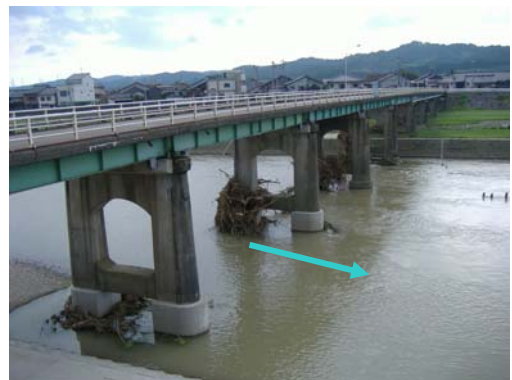
写真 5.5 出水後の流木の状況
