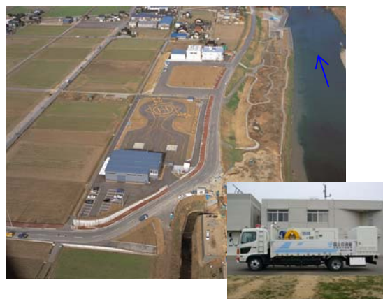
写真 5.6 福岡防災ステーション
