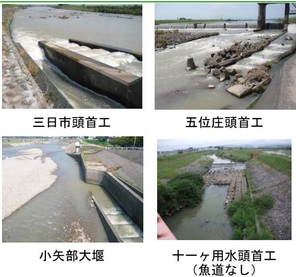
写真 3.11 横断工作物の魚道の設置状況
