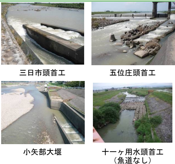
写真 3.11 横断工作物の魚道の設置状況
