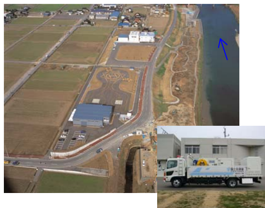
写真 5.6 福岡防災ステーション
