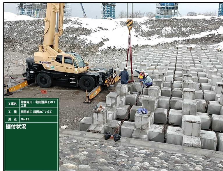
根固めブロック据付も、あと5日ほどで完了します。この後は、仮置きしている土砂で護岸の埋戻しを行い、工事は竣工となります。
