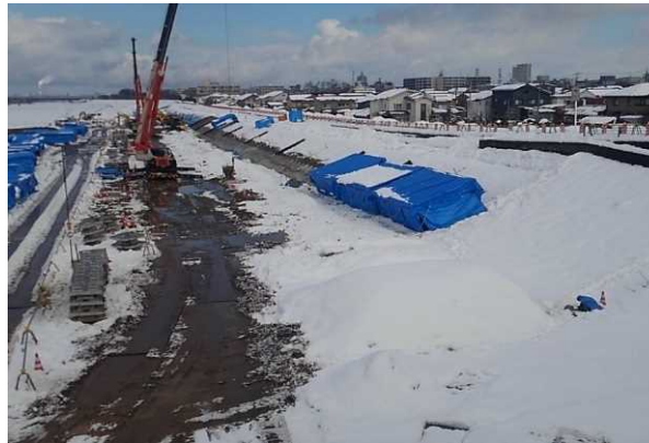
大型ブロック積工施工中（1月20日撮影）
