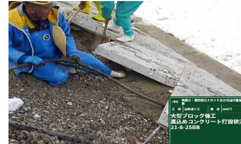
裏込めコンクリート打設状況
