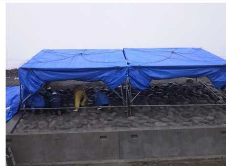
雨天時施工状況
