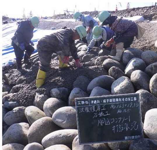
石張施工状況
