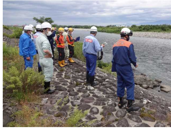
低水護岸の点検【神通川】
