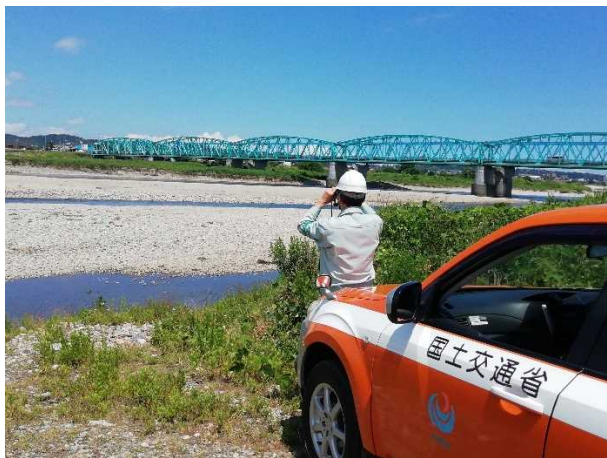
【神通川】定期パトロール (一般巡視)
