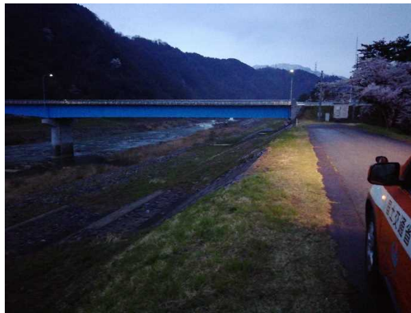
【庄川】夜間巡視(目的別巡視)
