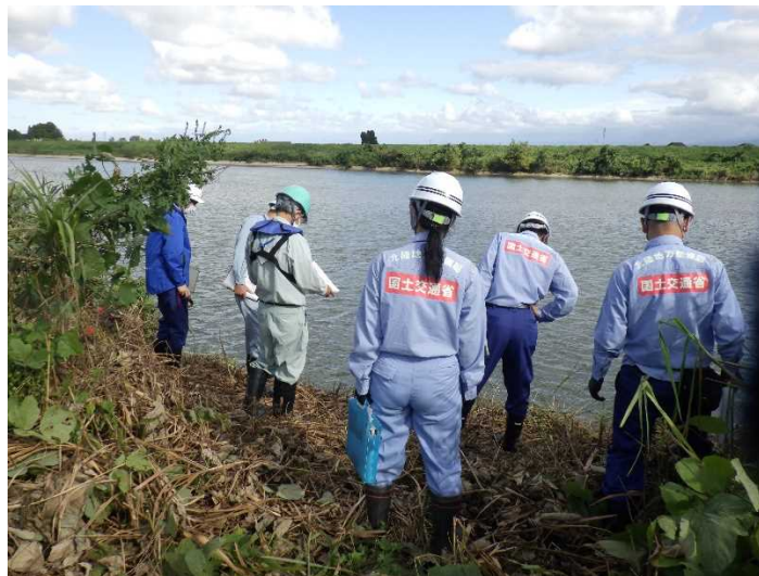
【小矢部川】河岸侵食状況の点検
