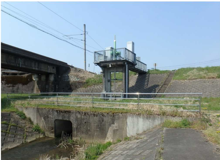
福町第二排水樋管【小矢部川水系小矢部川】
