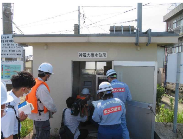
神通大橋水位観測所【神通川】
