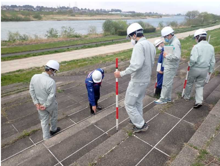
【神通川】親水護岸の点検 R4. 4. 13
