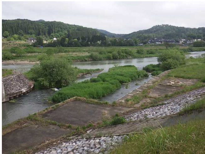
【小矢部川】坂又川樋門 伐採前
