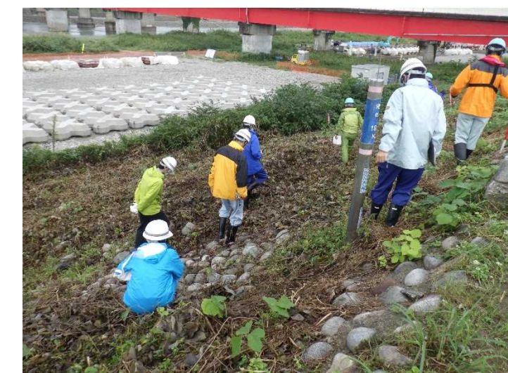
【庄川】蛇籠張護岸の点検
