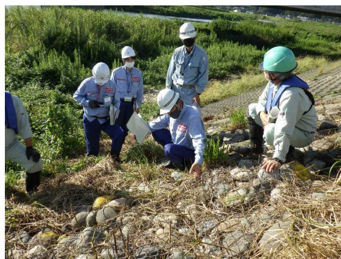
【小矢部川】蛇籠張護岸の点検
