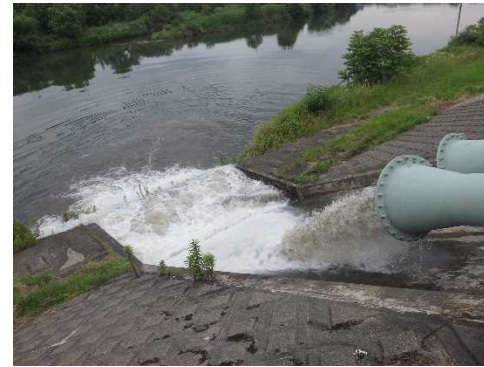
四屋排水機場
