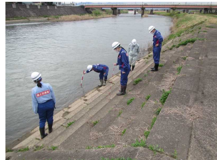
【小矢部川】親水護岸の点検 R4. 4. 19
