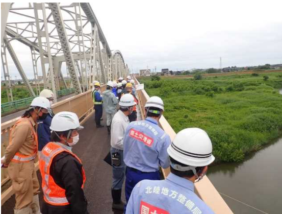
河道状況の点検【常願寺川】
