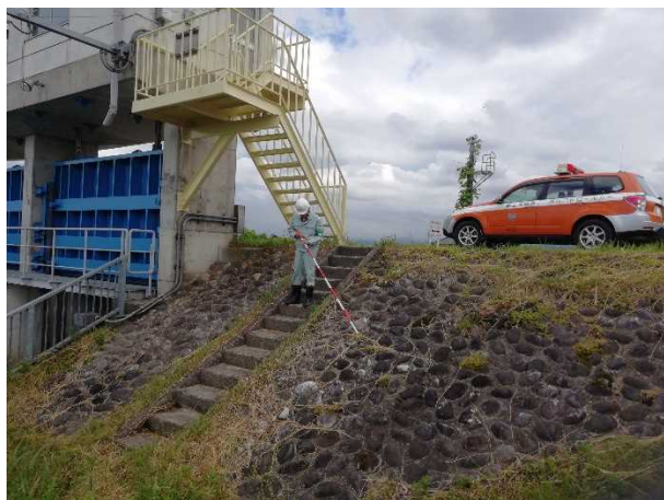
【神通川】護岸点検(目的別巡視)
