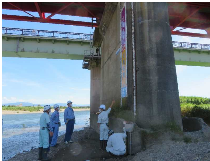
大門水位観測所【庄川】
