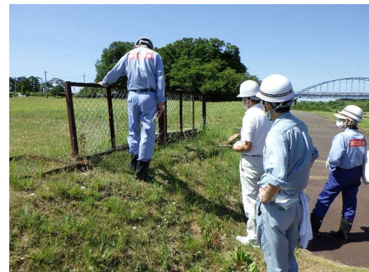
【庄川】フェンスの点検 R4. 7. 1
