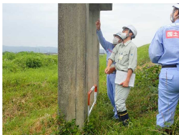
経田排水樋管
