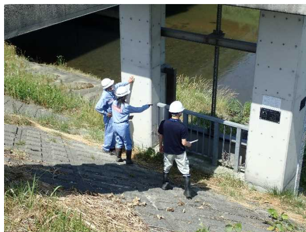
綾子排水樋門
