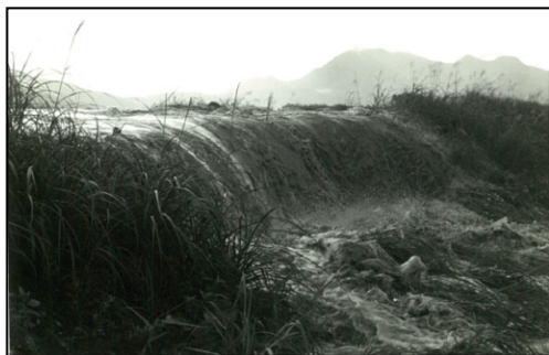
堤防越水(戸狩地先)
