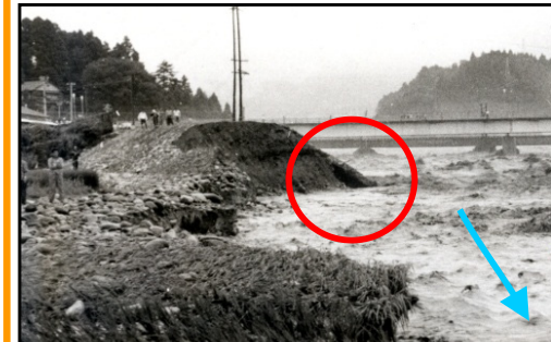
破堤時の堤防状況(護岸裏の吸い出し)
