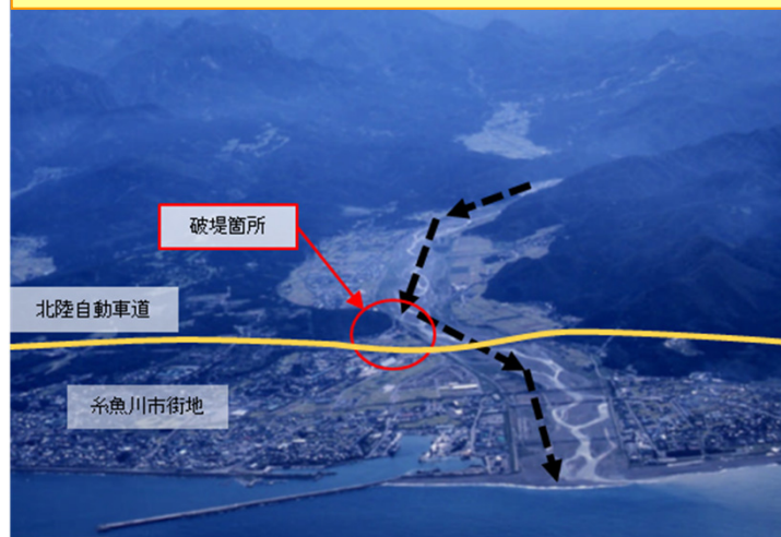
破堤箇所の位置
