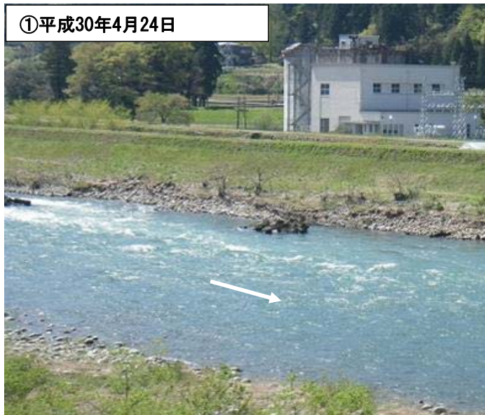
被災前の状況
