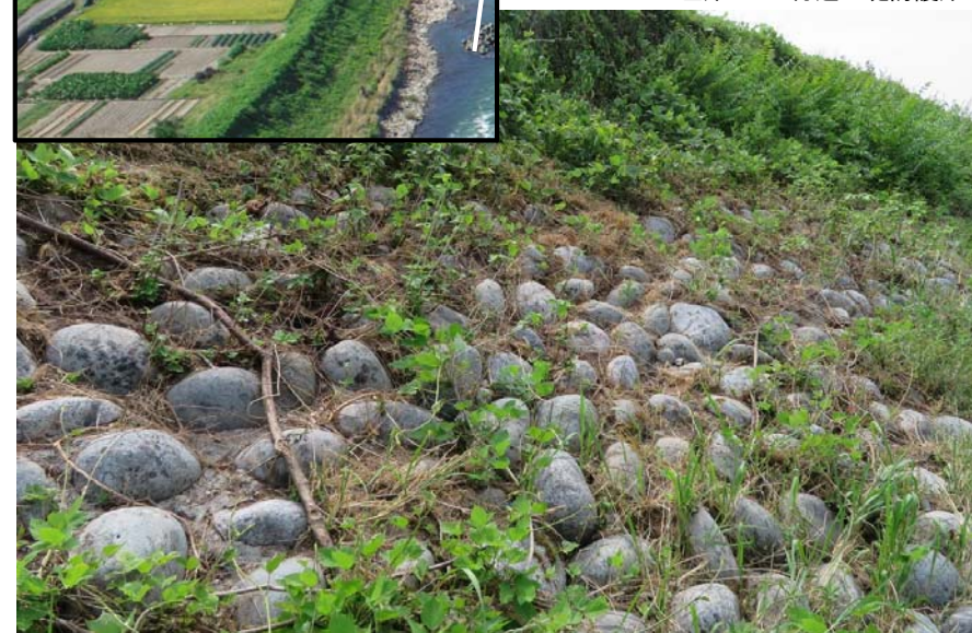
左岸22.6k付近の堤防護岸
