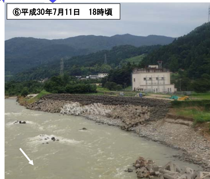
緊急復旧作業完了時の状況
