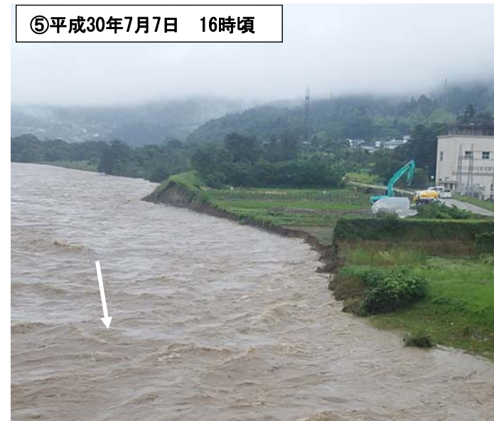
緊急復旧作業再開時の状況
