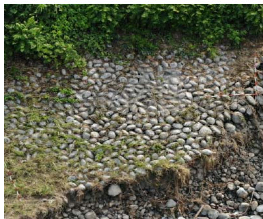
堤防欠損箇所上流の空石張り護岸
