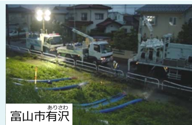
内水被害の状況（H16.10洪水）
