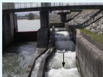
井田川合口頭首工の魚道 (富山市八尾町上高善寺)
