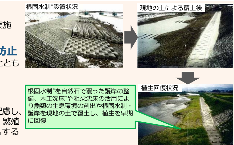
護岸前面の覆土による植生の早期回復事例
