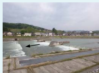
大坪用水堰 (富山市八尾町福島)
