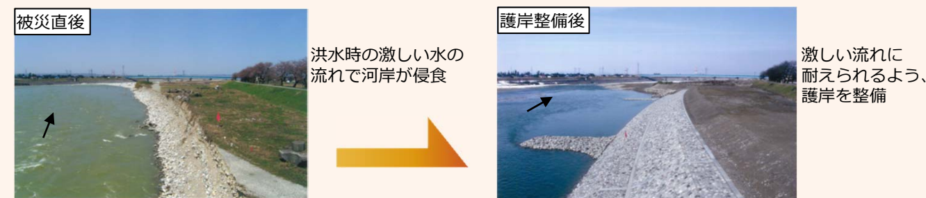
H16.10洪水で被災した箇所の護岸整備の例（富山市塩）
