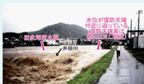
改築前の大坪用水堰*（富山市八尾町福島）の洪水時の堰上げ*状況（H2.9洪水）
