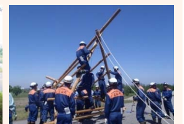
水防工法研修
