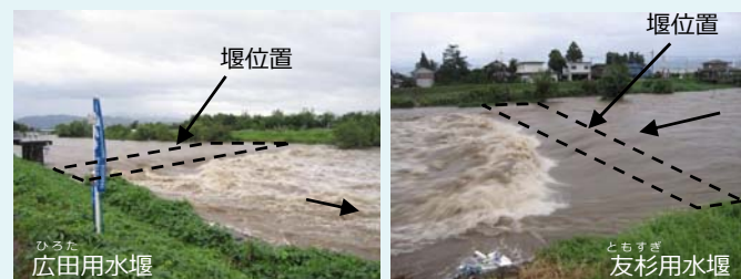
洪水の安全な流下に支障となる施設（富山市友杉）
