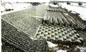
根固*水制設置状況
