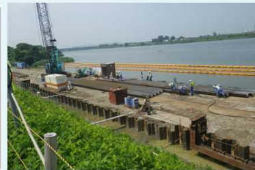
▲耐震対策実施事例 (富山市西宮地先)
