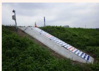
▲簡易水位計及び量水標の設置 (富山市婦中町羽根地先)
