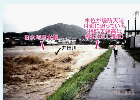
▲改築前の大坪用水堰*（富山市八尾町福島地先）の洪水時の堰上げ*状況（H2.9洪水）
