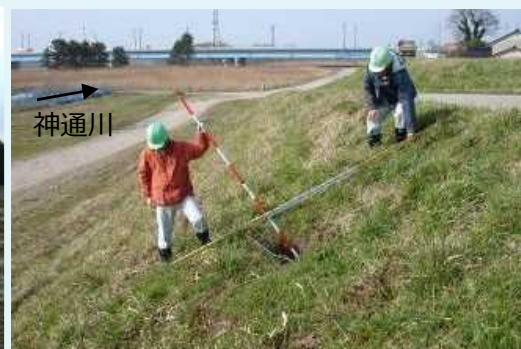
▲平常時の巡視・点検状況 (富山市上野新地先)
