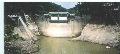
▲室牧ダム貯水池の様子（H6.8.18）
